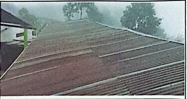
Foto 5: la lamina ya esta deteriorada por el paso del tiempo y tiene que ser replazada.
