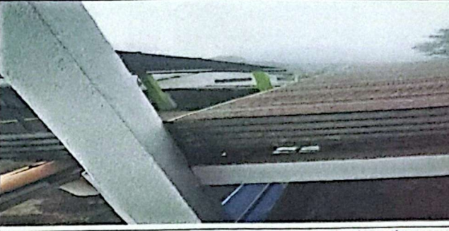
Foto 6: los canales de la bajada de agua no son las indicadas y tiene que ser replazada.
